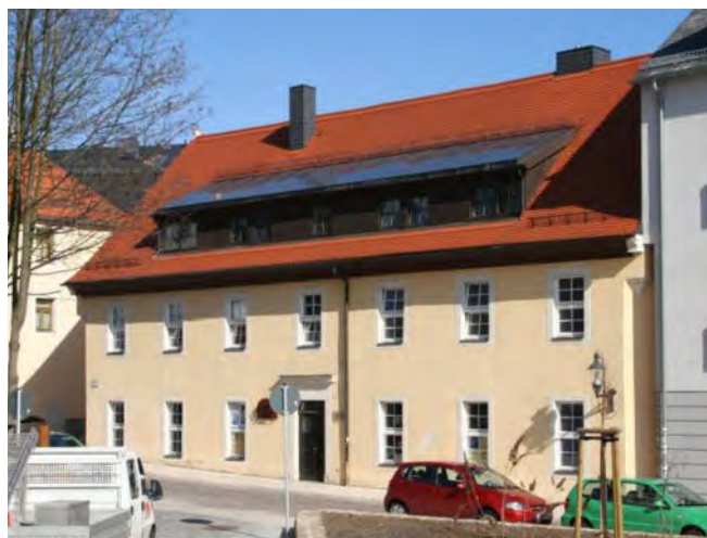
Abb. oben: Aufdach-Anlage, schwarze Module auf schwarzem Dachziegel Abb. unten: PV-Deckung der Gaube des denkmalgeschützten Hauses
