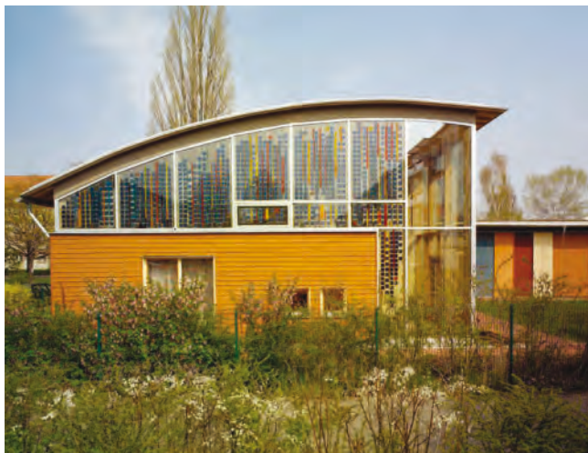
Abb. oben: Photovoltaik wurde mit farbigen Gläsern kombiniert. Abb. unten links: Südfassade eines Kindergartens mit künstlerisch gestalteter PV-Anlage Abb. unten rechts: Detail
