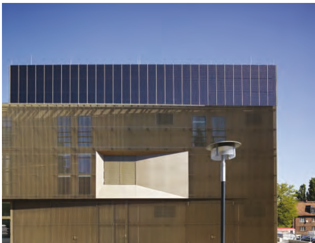
Abb. oben: Laborgebäude: Südfassade und Dachgeschoss mit vorgehangenen PV-Modulen Abb. unten links: Forschungsgebäude: flächige Fassadengliederung mit PV-Modulen Abb. unten rechts: Schulgebäude: Die Technikzentrale auf dem Dach ist mit PV-Modulen verkleidet.
