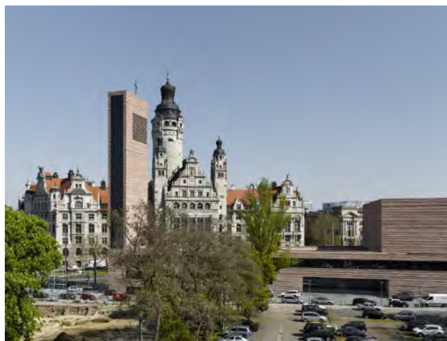
Abb. oben und unten: PV-Fassadenanlage an einem modernen Kirchturm
