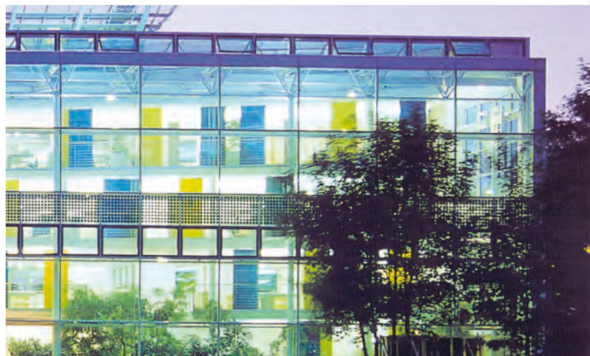
Abb. oben: PV-Module in Streifen integriert in Glasfassade eines Bürogebäudes Abb. unten: PV-Zellen auf Abstand in die 3-Scheiben-Isolierverglasung eingebaut, dadurch fällt Licht durch die PV-Glasfassade.
